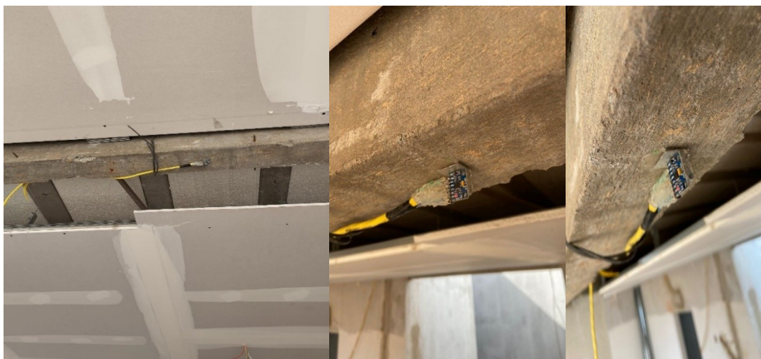
Figura 8 - Sensor MPU-6050 na viga.
