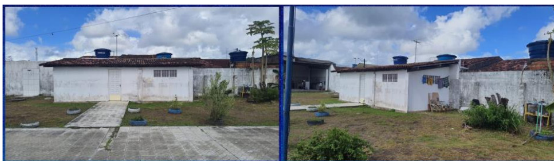
Figura 06 - Imagens da Nova Sala de Recursos Multifuncionais
